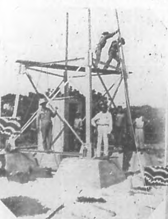
Los obreros armando la torre de uso de los nuevos faros
