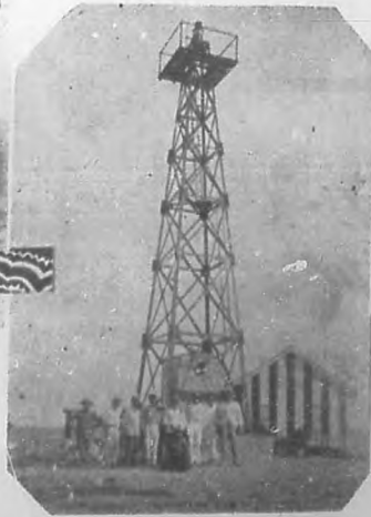
El nuevo faro de "Cayo Cristo", momentos después de quedar armado
