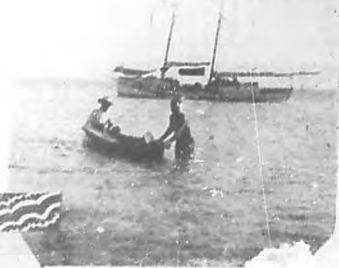
El bote de la goleta "A" transportando materiales a "Cayo Verde", para la construcción del faro
